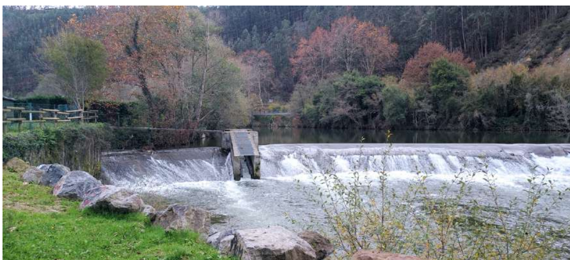
Azud de la central hidroeléctrica de Marrón (municipio de Ampuero), con ralentizador o escalera de peces. Fuente: colección de la autora.
